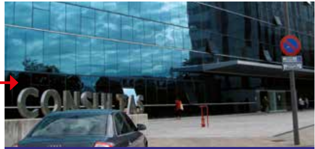
EDIFICIO DE CONSULTAS.
